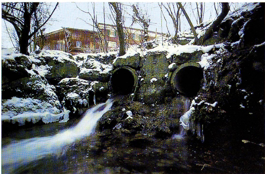
Abb. 7: Herrenmühlibach bei Herenmüli, wo er in Röhren verschwindet. Diese künstlichen Abstürze und Verrohrungen verhindern die Durchgängigkeit für Wasserorganismen.
