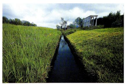
Abb. 9: Moosbach-Unterlauf bei den Schrebergärten in einem naturfremden Zustand. Die Linienführung ist begradigt. Böschung und Sohle bestehen aus harten Betonplatten. Die Ufervegetation besteht rechts aus Golfrasen.
