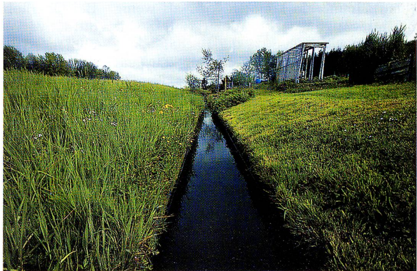
Abb. 9: Moosbach-Unterlauf bei den Schrebergärten in einem naturfremden Zustand. Die Linienführung ist begradigt. Böschung und Sohle bestehen aus harten Betonplatten. Die Ufervegetation besteht rechts aus Golffrasen.
