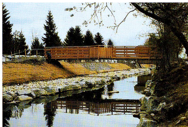
Abb. 26: Grosse Aa, Gemeinde Sempach: Brückenschlag über den revitalisierten Zufluss des Sempachersees, 12. 4. 1994.
