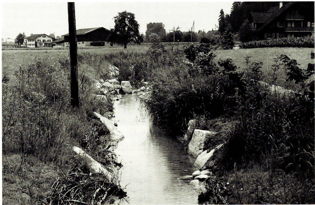
Abb. 3: Der Lippenrütibach wurde im Frühling 1992 renaturiert und wieder in ein «natürliches» Bachbett verlegt. Die Ufer wurden abgeflacht, mit Steinen befestigt und mit Sträuchern bepflanzt.
