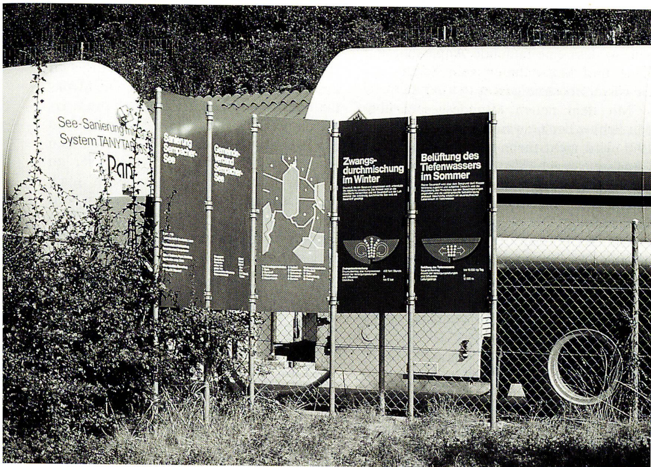
Abb. 3: Landanlage in Eich. Von hier aus werden die see-internen Anlagen gesteuert; der Sauerstoff wird in Tankfahrzeugen angeliefert.
