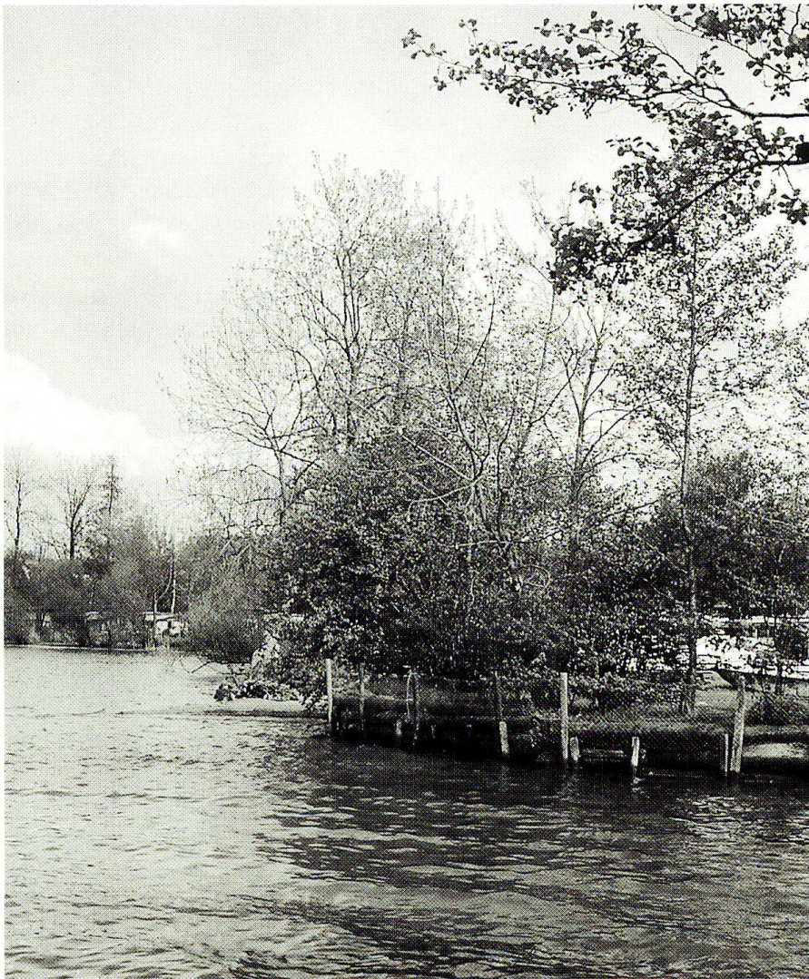
Abb. 8: Hartverbau der Wasserlinie mit Holzpalisaden gegen fortschreitende Ufererosion bei der Mündung der Grossen Aa.
