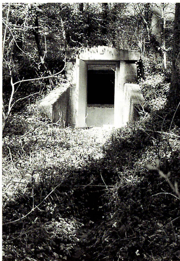
Abb. 3: Brunnenstube mit Überlauf der Quellwasserfassungen Tannberg im Chommlibachtobel. Die Tannberg-Quellen (Wasserversorgung Sursee) liefern 90 bis 300 Liter Quellwasser pro Minute.
