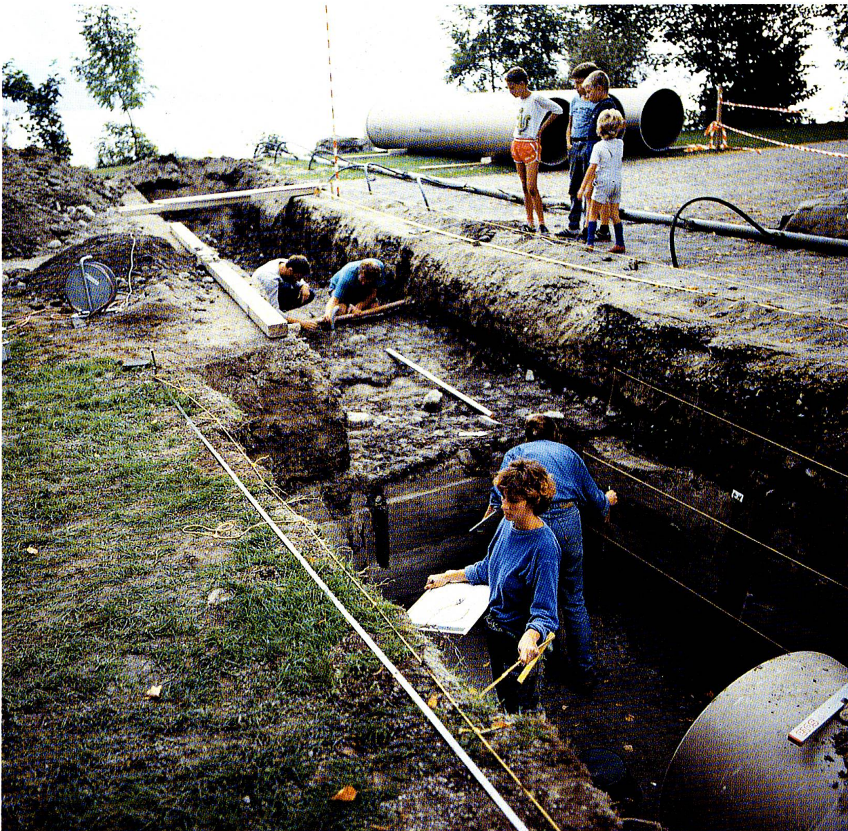
Abb. 2: Anlässlich einer Verlegung eines Überlaufkanalrohres bei der Festhalle Sempach wurde 1987 eine frühbronzezeitliche Kulturschicht entdeckt. Das Bild zeigt die hektische Situation anlässlich der rasch einberufenen Notgrabung; während die zur Verlegung bereitliegenden Rohre warten, ist es noch möglich, eine geringe Fläche und ein Wandprofil des Grabens zu präparieren und zu dokumentieren.
