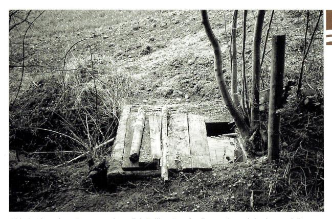
Abb. 5: Alte, private Brunnenstube östlich Zollhus. Das Quellwasser ist untief gefasst und die Brunnenstube mit einer morschen Holzabdeckung versehen. Solches Quellwasser erfüllt die Anforderungen an die bakteriologische Reinheit nicht.
