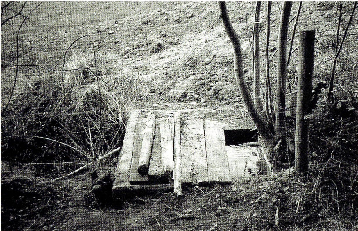
Abb. 5: Alte, private Brunnenstube östlich Zollhus. Das Quellwasser ist untief gefasst und die Brunnenstube mit einer morschen Holzabdeckung versehen. Solches Quellwasser erfüllt die Anforderungen an die bakteriologische Reinheit nicht.
