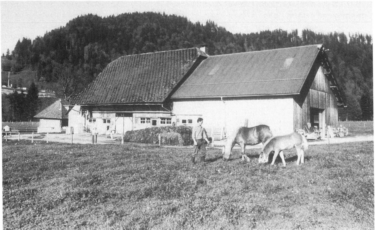
Abb. 3: Sanierter Hof «Linden».
