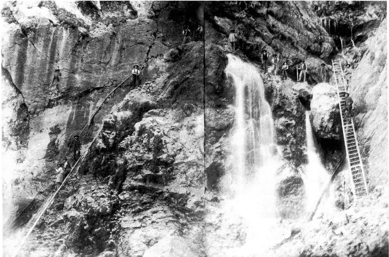
Abb. 6: Ansicht der Bründlenquelle bei Beginn der Fassungsarbeiten 1888.
