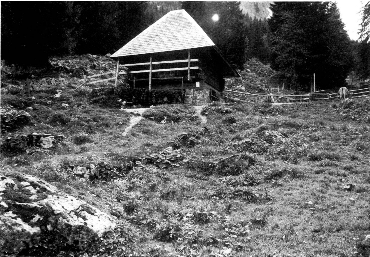
Abb. 4: Wegbauliches Element des alten Talweges vor der Alp Stafel: Unter Vegetationsbewuchs kommt eine talseitige Randpflasterung zum Vorschein. (Foto mf, 6.1991)
