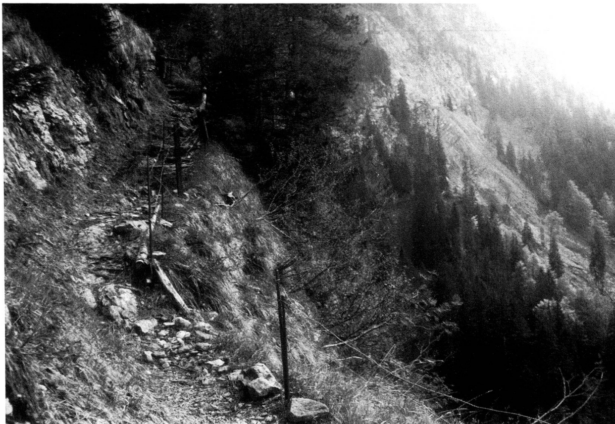
Abb. 6: Blick auf den 1735 errichteten Bründlenweg. Die Wegbreite ist grösser als am Fruttweg, die Ausgesetztheit stellenweise beträchtlich. Der Fels ist bergseits bearbeitet, talseitig stützen örtliche Trockenmauern das Trasse. (Foto mf, 6.1991)
