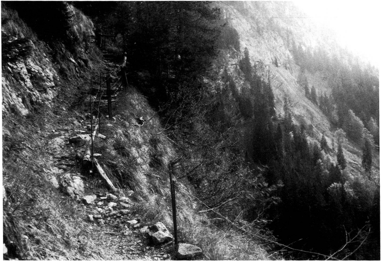
Abb. 6: Blick auf den 1735 errichteten Bründlenweg. Die Wegbreite ist grösser als am Fruttweg, die Ausgesetztheit stellenweise beträchtlich. Der Fels ist bergseits bearbeitet, talseitig stützen örtliche Trockenmauern das Trasse. (Foto mf, 6.1991)
