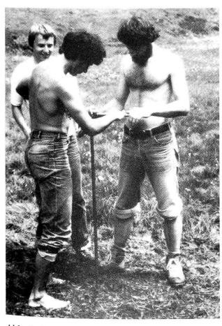
Abb.6: Bei den Bohrarbeiten mit der Dachnowsky-Sonde.
