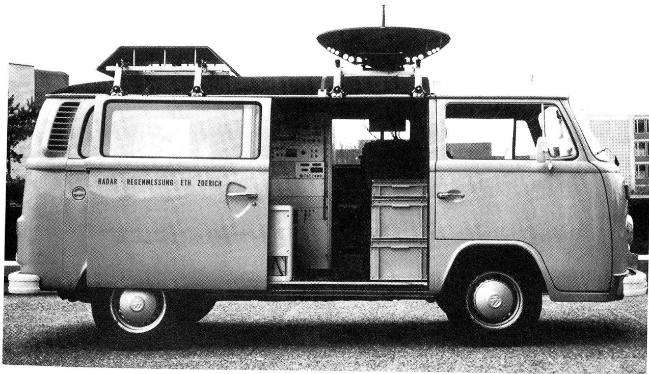
Fig. 15: Der Doppler-Radar-Bus der Atmosphärenphysik ETH. Auf der Mitte des Daches ist die Antenne des Radars ersichtlich, hinten das Distrometer. An der hinteren Dachkante ist bei Messeinsätzen zusätzlich ein Wippenregennmesser befestigt.
