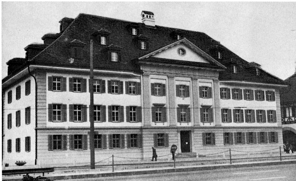
Neues Museumsgebäude (rekonstruiertes Waisenhaus)
