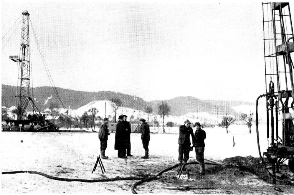
Bohrung Altishofen, rechts Bohrgerät für seismische Bohrlöcher, benutzt für die seismischen Messungen im Bohrloch der Tiefbohrung, ausgeführt von der deutschen Ölgesellschaft Elwerath. Links Bohrturm der ITAG.
