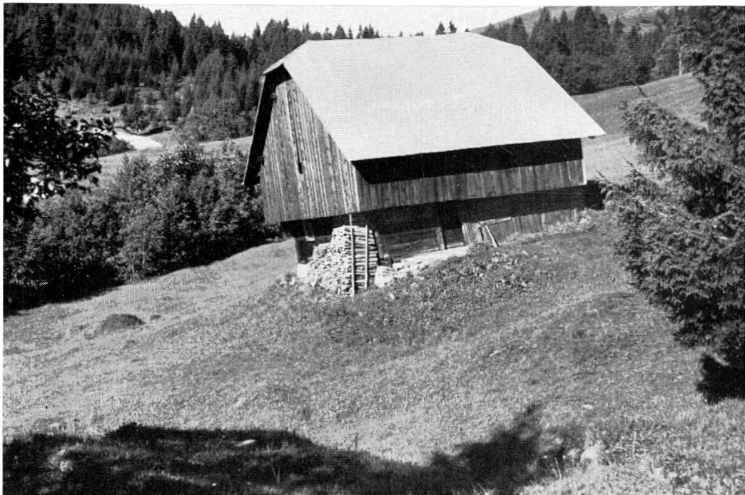
Abb. 4 Schiefstehender Heuschober im Rutschgebiet bei Egghütten
