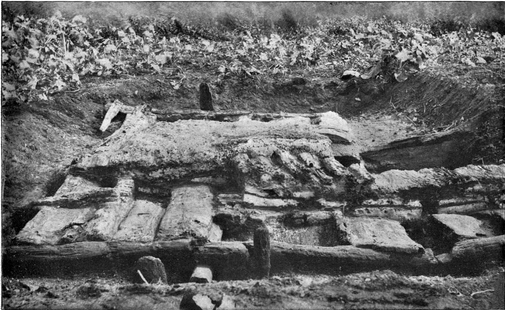
Schötz I. Pfahlhaus Meyer. Mittlere Partie. Im Vordergrund die Eichenplanken von Boden I auf ihren Längshölzern.
