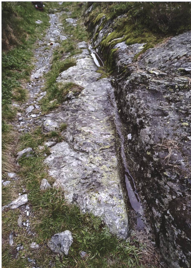
Abb. 2: Abschnitt des intakten Römerweges im Malojagneis bei Plan di Mort am Nordufer des Silsersees (Foto: St. Altner).
