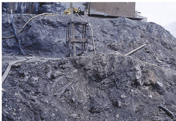
Abb. 3: Baugrube Chesa Corviglia (Baubeginn 1980), Aushub in der chaotischen, verflochtenen Sturzmasse (Foto: Ch. Schlüchter).
