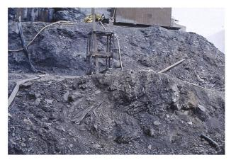
Abb. 3: Baugrube Chesa Corviglia (Baubeginn 1980), Aushub in der chaotischen, verflossenen Sturzmasse (Foto: Ch. Schlüchter).
