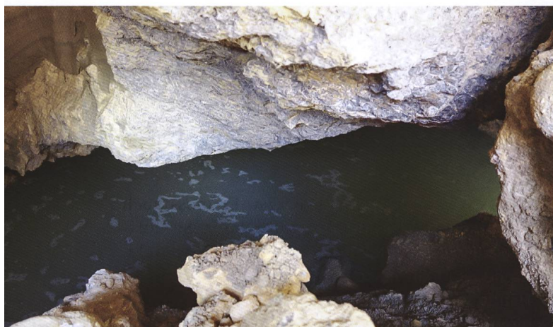
Abb. 7: Aufgebrochener Karsthohlraum in der gipsführenden Raibler-Rauhwanke aus der Trias. Baustelle Kläranlage Furnatsch bei S-chanf (Foto: Th. Rüegg).
