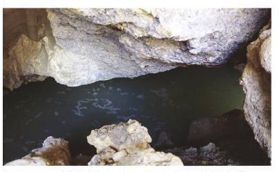
Abb. 7: Aufgebrochener Karsthohlraum in der gipsführenden Raibler-Rauhwacke aus der Trias. Baustelle Kläranlage Furnatsch bei S-chanf (Foto: Th. Rüegg).
