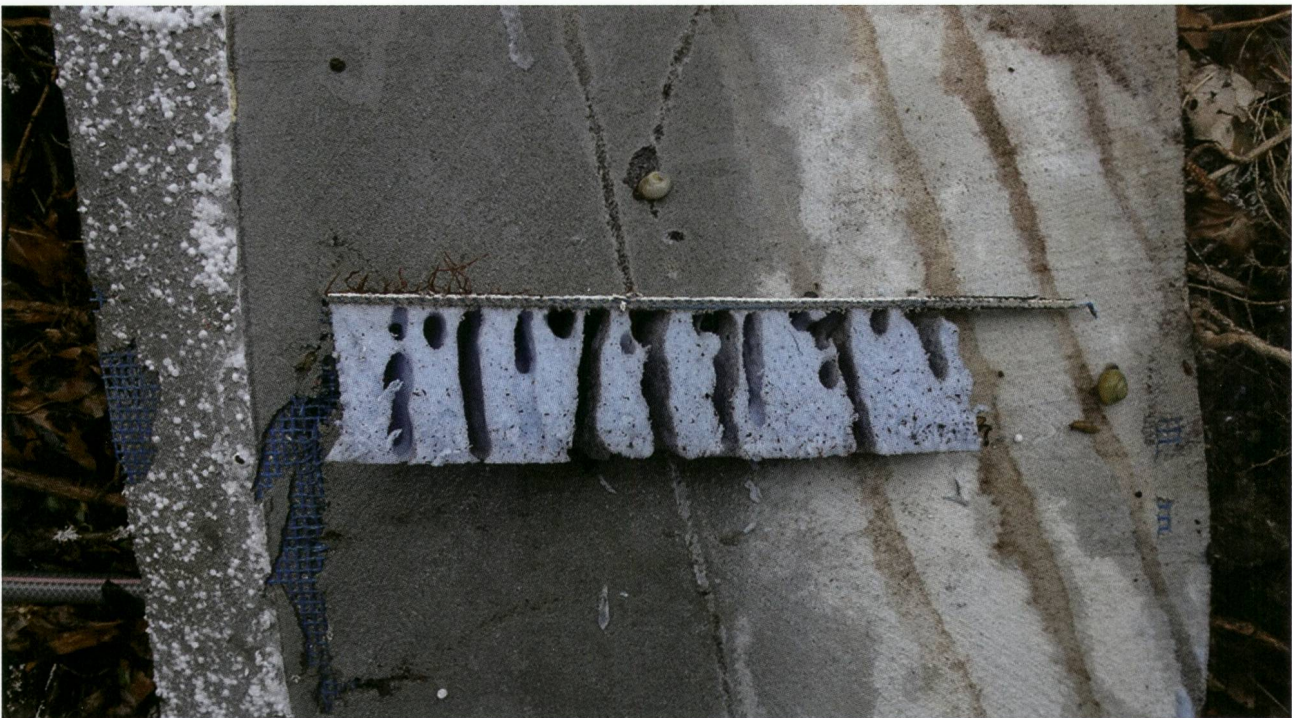
Abb. 2: Dieses Nest der Braunschwarzen Rossameise Camponotus ligniperdus fand Franco Isepponi in der Isolation eines Hauses in Tamins (Foto: F. Isepponi).
