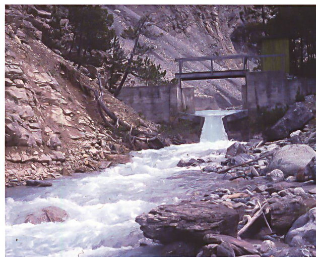
Abb. 9: Die bestehende hydrologische Messstation bei Punt la Drossa: Die hydrologische Datenreihe für das im Rahmen der Parkforschungen vielfältig untersuchte 55,3 km 2 grosse Einzugsgebiet der Messstation dürfte angesichts der Klimaänderung an Wert gewinnen. Eine naturnahe Erneuerung der Station scheint deshalb prüfenswert – trotz etwas verminderter Genauigkeit und unabhängig vom Problem der Bachforellen (Foto: Bernhard Nievergelt, 5.7.1990).
