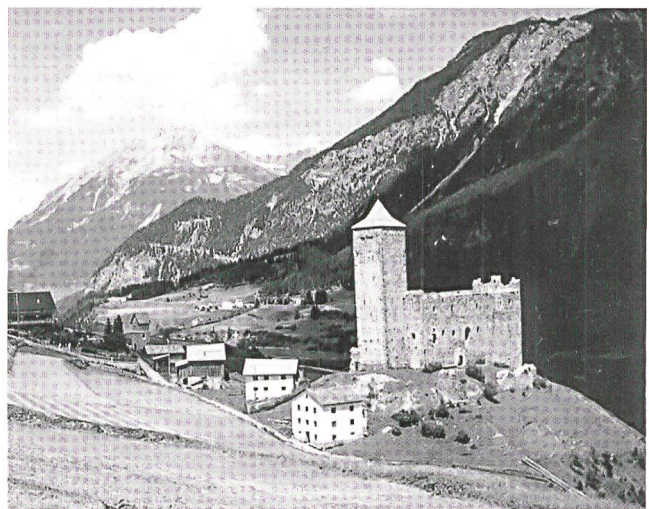
Abb. 5: Die Ruine Rätia Ampla aus südwestlicher Richtung um 1945. (Foto: J. Martin).
