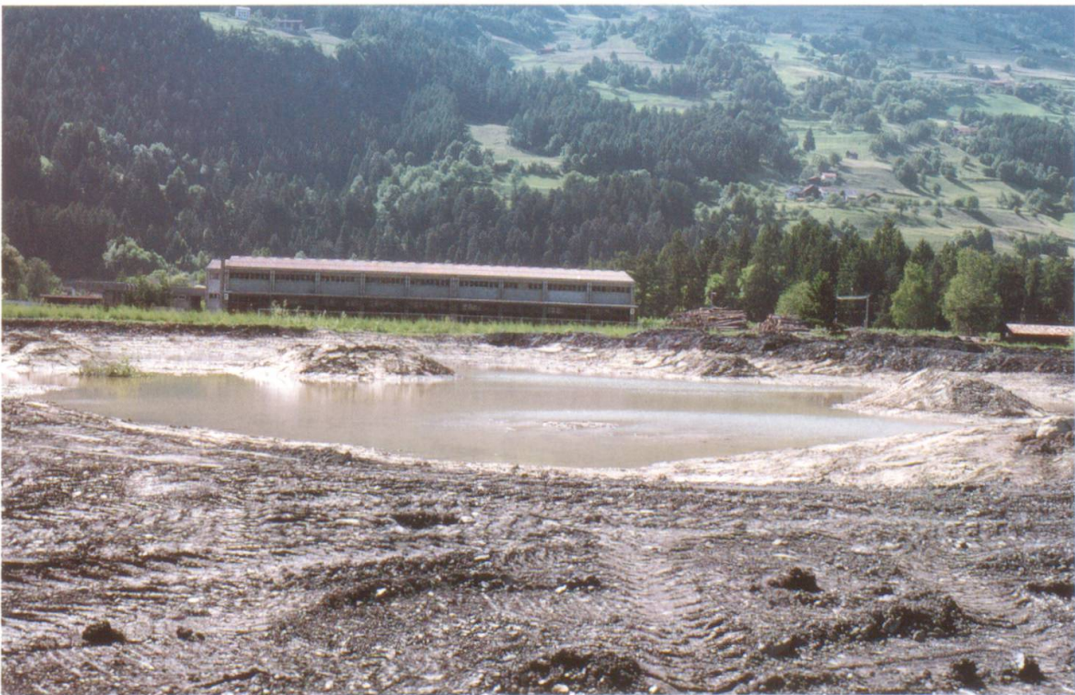
... entsteht mit Hilfe von Baggern eine Weiherrlandschaft. (Foto G. Ragaz)
