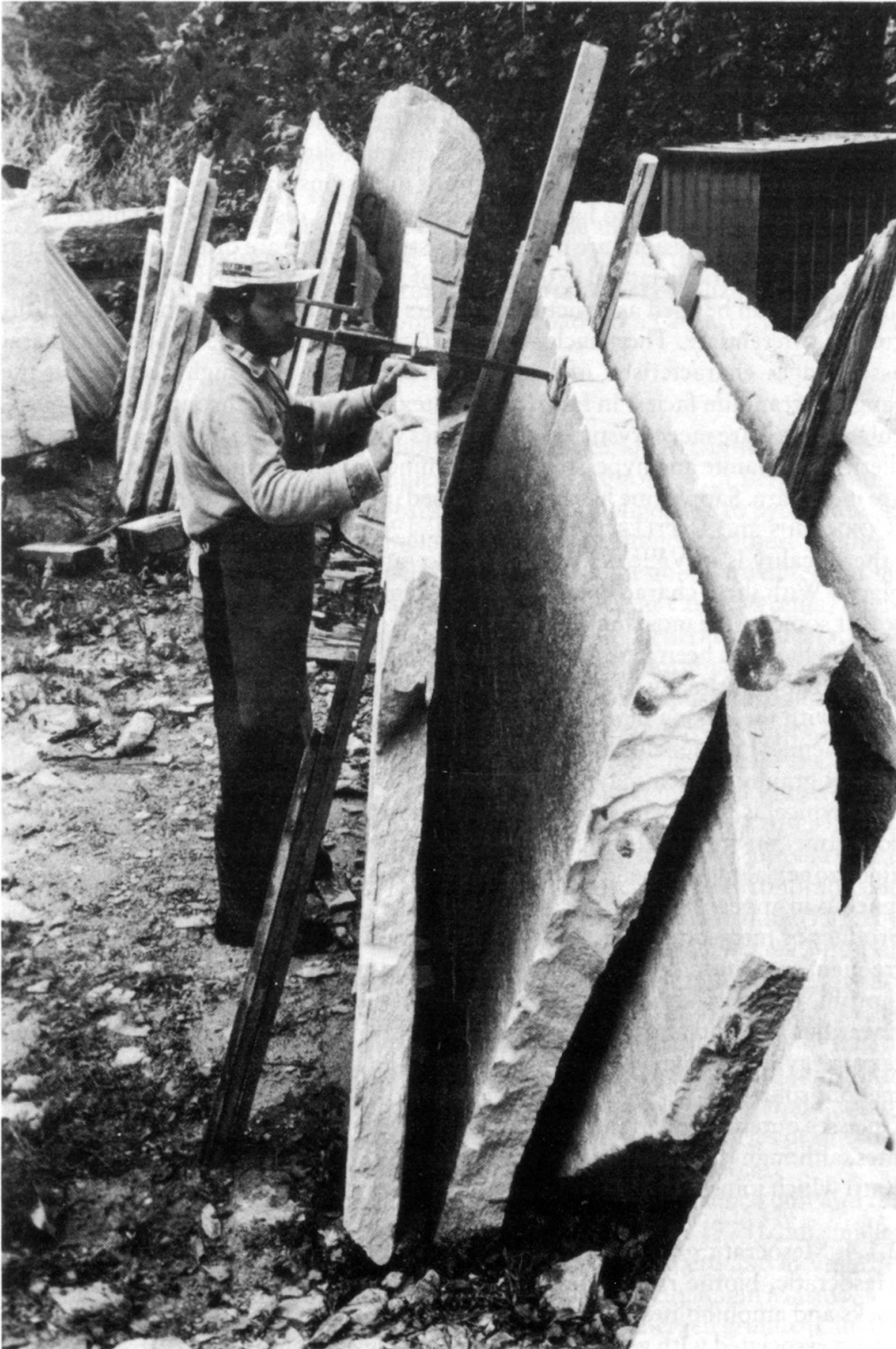
Figure 1. Large slab of Tambogneiss with perfectly planar surface. Schuhmacher quarry, Soglio. – Grosse Platte von Tambogneis mit perfekter Spaltbarkeit und Oberfläche. Steinbruch Schuhmacher unterhalb Soglio.
