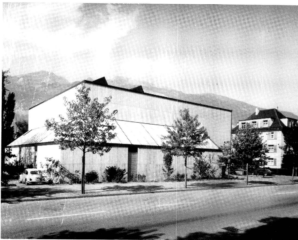
Ansicht von Südosten.
