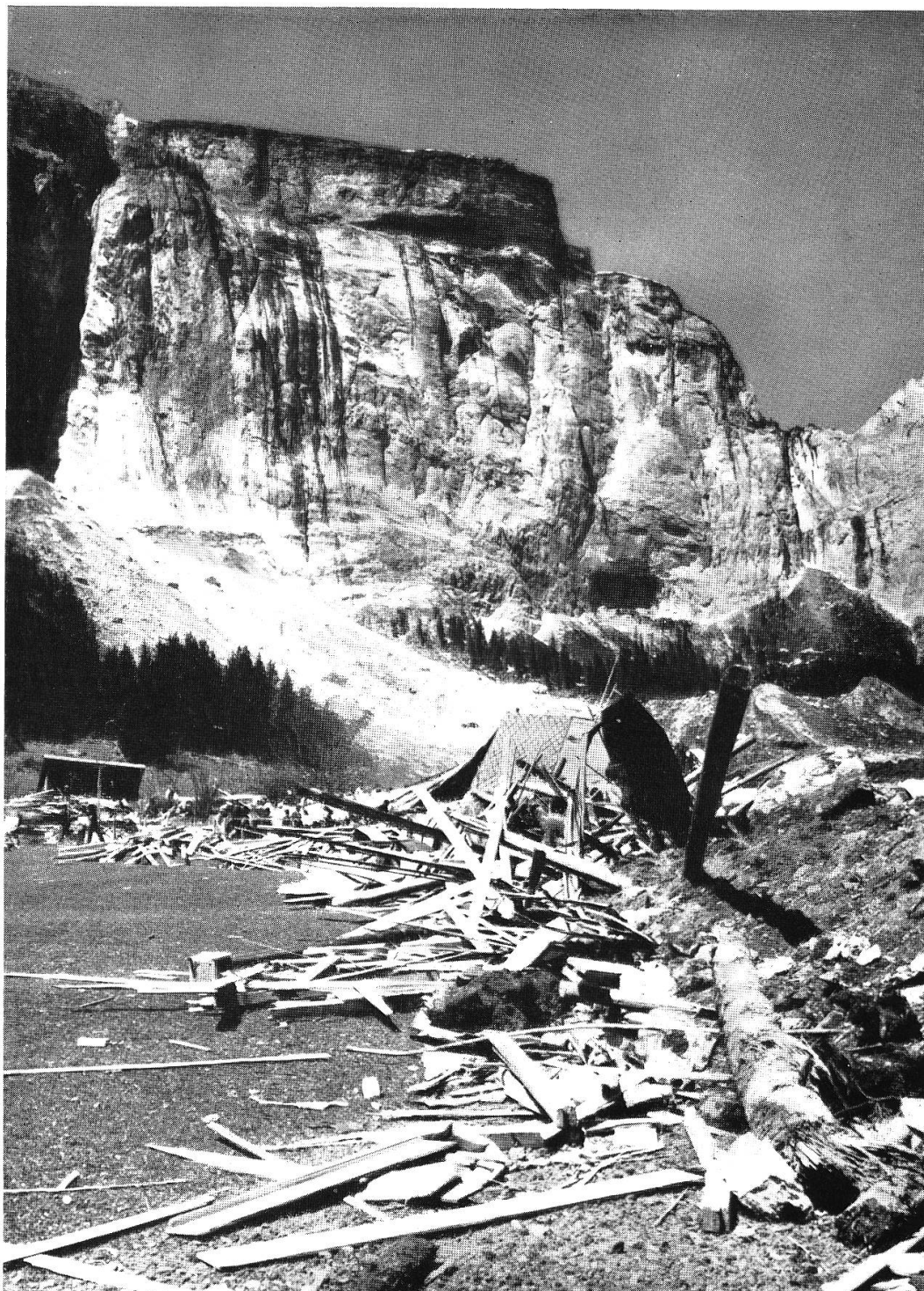
Abb. 8. Die Unglücksstätte. Das Gebäude, vom Rande des Schuttstromes erfaßt, liegt in Trümmern. Nur die Liegehalle (links) blieb verschont. — Das Abrißgebiet zeigt im unteren Teil deutlich die frische Bruchfläche. Weiter rechts zwei ältere Ausbruchnischen.
