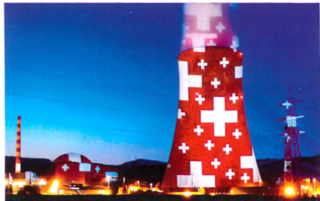
Abb. 6: Das Kernkraftwerk Gösgen gibt eine elektrische Leistung von rund 1 GW (ein Gigawatt) ans Stromnetz und 2 GW in der Form von Verdampfungswärme und erwärmter Luft an die Atmosphäre ab. Diese jährliche Energiemenge E von 3 Gigawattjahren gibt durch das Quadrat der Lichtgeschwindigkeit c dividiert gerade etwa 1 kg Masse m , die in Energie umgewandelt wurde: m = E/c^2 (Bild KKG).
