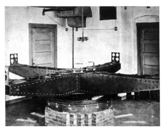
**Abb. 1:** Verbessertes Interferometer von Morley und Miller, das bei Messungen 1903–1905, wie die rund 20 Jahre früheren Messungen von Michelson und Morley keinen Ätherwind zeigte (Photo AIP Emilio Segre Visual Archives).
