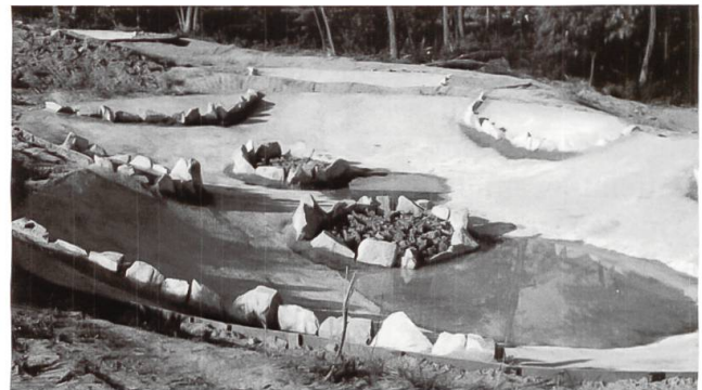
Abb. 5: Betonwanne mit Pflanznischen für Teich- und Seerosen, Wasserpflanzen sowie am Rand für Ufervegetation; der Randstreifen dient auch zur Sicherheit (vgl. Text). Damit lässt sich das Pflanzenwachstum örtlich begrenzen und eine spätere Reduktion ist einfacher möglich (vgl. Abb.11). Nach der Reinigung der Weihersole kann aus diesen Pflanzenrefugien auch eine rasche Neubesiedlung mit Mikroorganismen, Kleinkrebsen und Schnecken erfolgen
