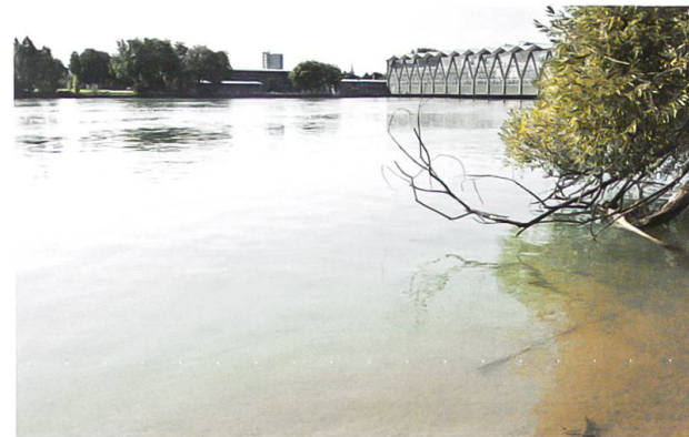
Foto 6: Lebensraumtyp Fließgewässer, Quellen: Rhein Oberwasser des Kraftwerks Birsfelden. Foto: Christopher Gmuender, MuttENZ
