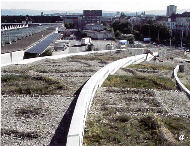
Abb. 2: Dachbegrünungs-Versuchsanlage Nordtangente (Autobahnteilstück Basel Nord–französischer Zoll, Überdachung der Tunneleinfahrt der Autobahn, Abschnitt Horburg) (a, Blick nach S). Auf der Rampenabdeckung des Abschnitts Horburg wurden unterschiedliche Schichtstärken an Oberboden (1 bis 4 cm) auf den im ersten Arbeitsgang aufgebrachten Wandkies verteilt. Die dadurch erhöhte Arten- und Strukturvielfalt bei der Vegetation soll auch bezüglich der Fauna bewirken, dass sich gesamthaft mehr Arten aus den umliegenden ehemaligen Bahnarealen (b) etablieren können als auf den reinen Wandkiesflächen.
