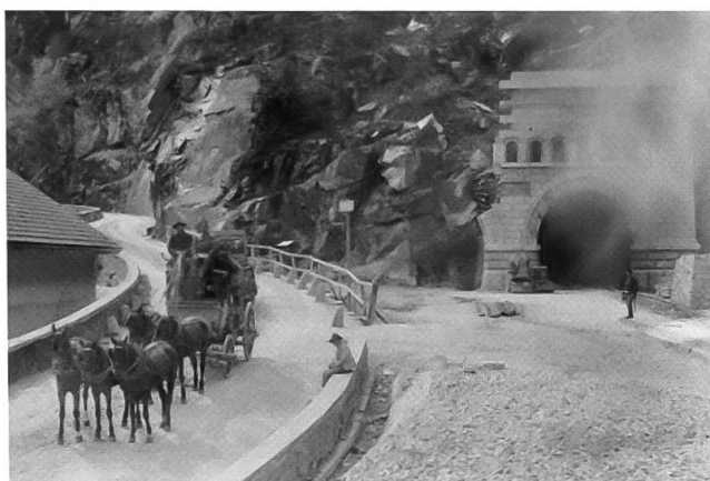
Abb. 7: Südportal des Simplontunnels (rechts Tunnel I, links Parallelstollen) während der Bauphase. Links daneben verkehrt die Pferdepost auf der Strasse zum Simplonpass. Photo: Fotoarchiv SBB Historic.
