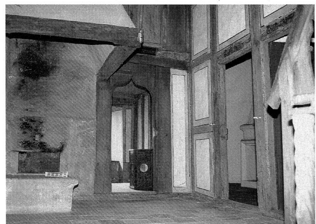
Abb. 5: Blick in das dritte Obergeschoss des Wohnturmes. Links im Vordergrund die offene Feuerstelle mit Kaminschoss, in der Bildmitte die Kielbogenöffnung des Kaplanszimmers und rechts der Eingang zur Rüstkammer. (Foto Bildarchiv Kantonale Denkmalpflege, Liestal)
