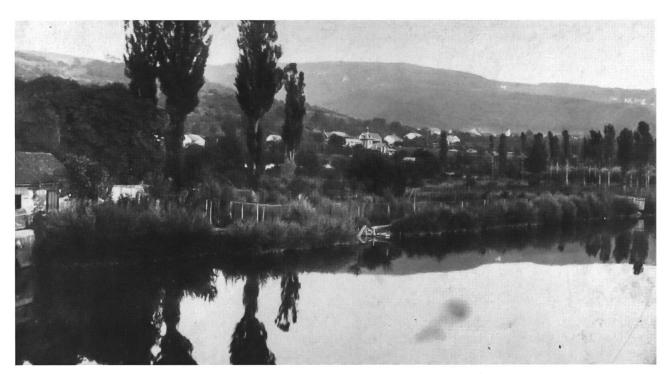
**Abb. 19:** Birs bei Dornachbrugg 1895 (also noch vor der Korrektion von 1900). Die Uferlinie gegen den Hauptarm ist mit Faschinen gesichert. Das dahinter liegende Weidengebüsch ist von Wasserläufen, in denen Wasserpflanzen gediehen, durchzogen. Die Bäume sind weitgehend abgeholzt. Die Funktion der zaunartigen Holzkonstruktion ist unklar. (Fischzuchtanstalt?). Die Birs war durch ein Wehr der Schappe-Fabrik leicht aufgestaut.
