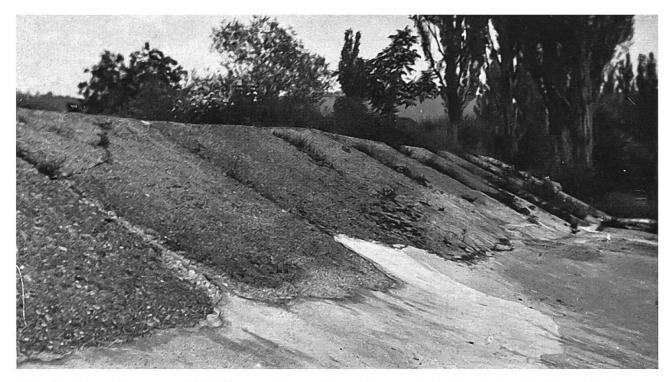
**Abb. 32:** Dornachbrugg um 1900. Neu geschütteter Damm kurz nach der Korrektion. Der Damm ist im unteren Teil mit einer Pflasterschicht befestigt, im oberen humusiert und noch kaum bewachsen (im Projekt war eine Begrasung vorgesehen). Die Humusierung ist vom Regen z.T. wieder wegerodiert. Auf solchen Dämmen, wie sie um die Jahrhundertwende zahlreich entstanden, konnten sich grossflächig Ruderalgesellschaften ausbreiten.
