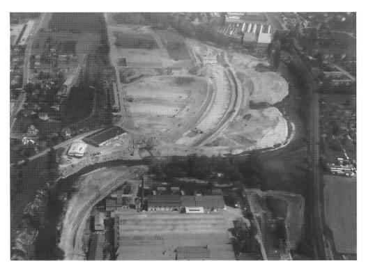
**Abb. 39:** Birskorrektion von 1971 nördlich der Metallwerke (Luftaufnahme). Die Birs wird in ein neues begradigtes Bett verlegt. Man versuchte mit einer landschaftsarchitektonischen Begleitplanung das Projekt einigermassen naturverträglich zu gestalten. «Nach Fertigstellung des Bauwerkes ging es darum, die harten technischen Zäsuren zu mildern und durch gezielte grünplanerische Mittel wieder einen naturnahen Landschaftsraum aufzubauen...» (Wiede 1974).
