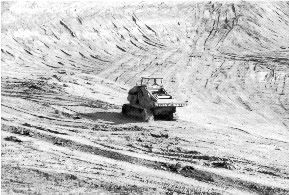
Abb. 6: Mit dem Schürfkübel – einer auf Breitraupen fahrenden Maschine – wird der Lösslehm abgehobelt und zu den Fabrikationsgebäuden transportiert. (Photo K. Wyss)
