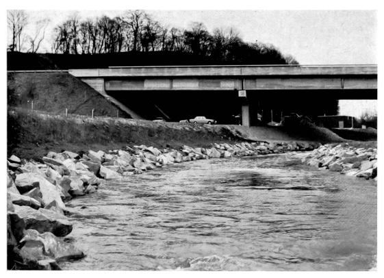
Abb.38: Der Hochleistungsstrassenbau kann auch Gewässerkorrektionen nach sich ziehen
