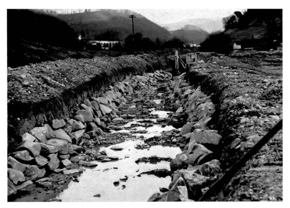
Abb.35: Die Korrektion eines Fliessgewässers als irreversibler Eingriff in den Naturhaushalt
