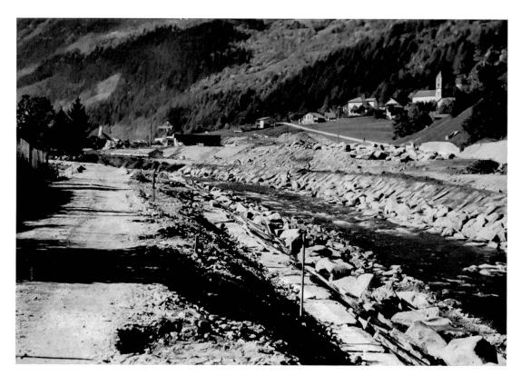
Abb. 36: Begradigung und Befestigung eines Flusses
