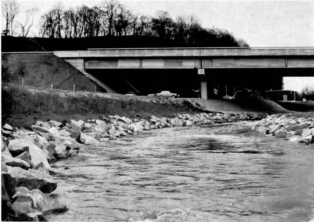
Abb.38: Der Hochleistungsstrassenbau kann auch Gewässerkorrekturen nach sich ziehen
