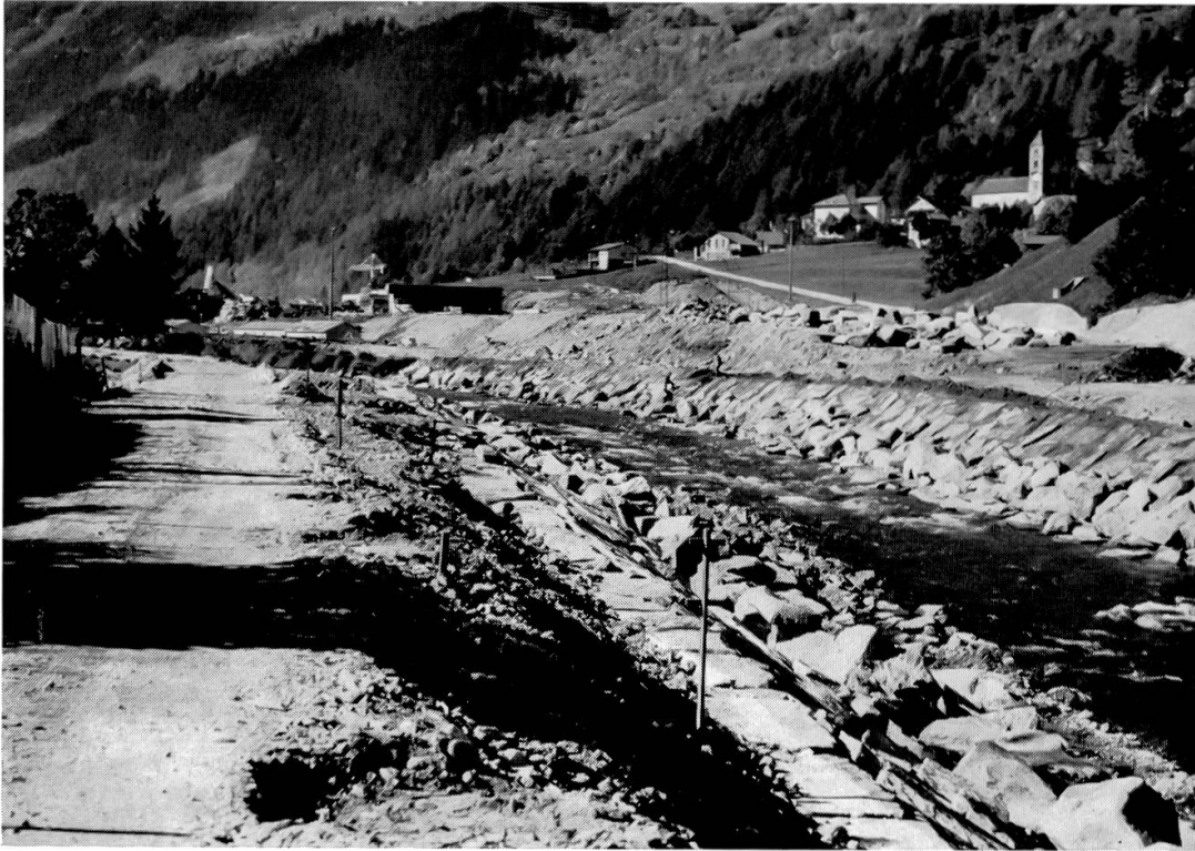
Abb.36: Begradigung und Befestigung eines Flusses
