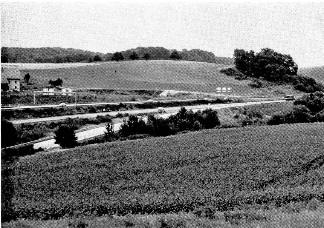
42 und 43: Die Fotos von 1970, 1975 und 1978 dokumentieren den Landschaftswandel im Zusammenhang mit dem Nationalstrassenbau
