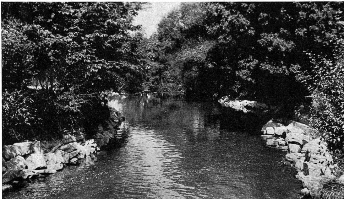
Abb. 1. Der Flusslauf der Ergolz in Schöntal mit den neuen Uferverbauungen. Aufnahme 9. September 1973.
