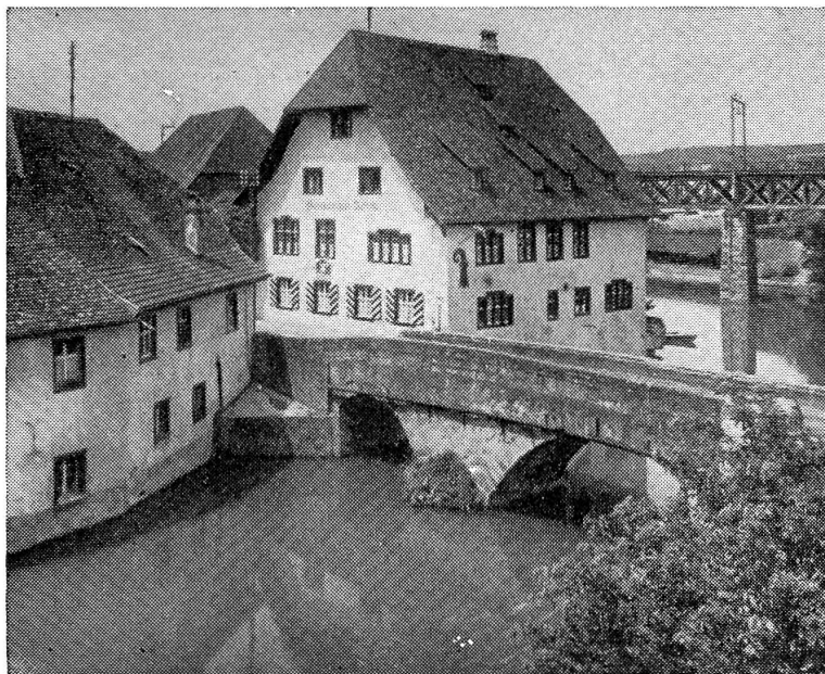
Abbildung 2. Ergolzbrücke in Augst. (Phot. Dr. TH. GUBLER †, Basel.)
