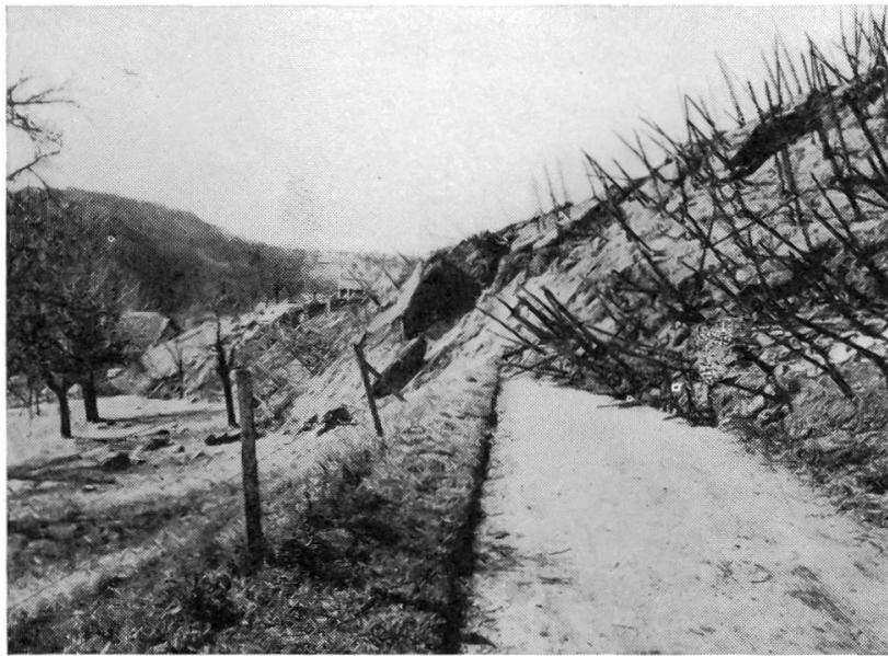
Abbildung 27. Mittlere Teilrutschung. Überschiebung des Wulstes der «Stein»-Scholle auf die Weinhagstrasse am südöstlichen Rand der Rutschung.
