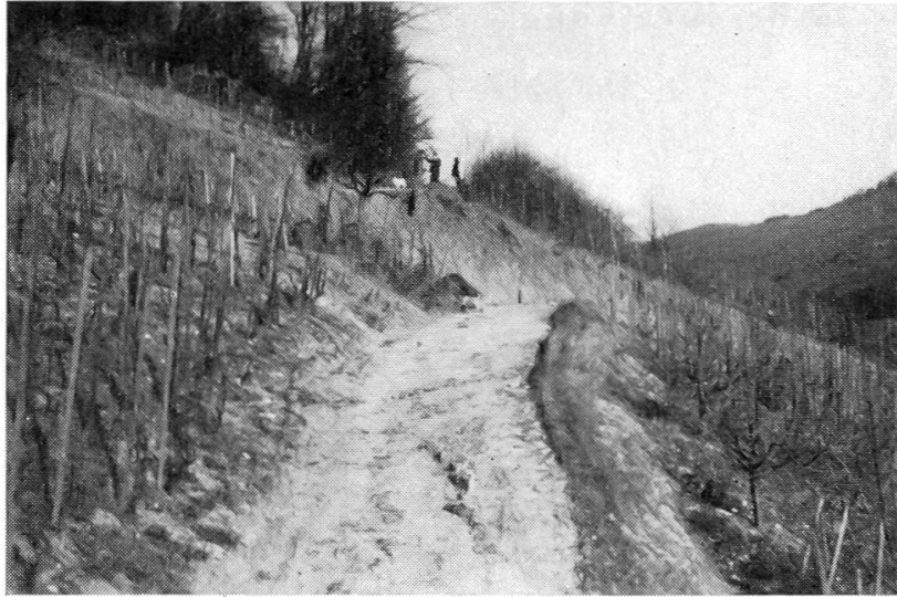
Abbildung 18. Abriss am südöstlichen Rand der Rutschung mit Verschiebung des Hallenweges. Photo des Verf. 8. April 1952, etwa 16 Uhr
