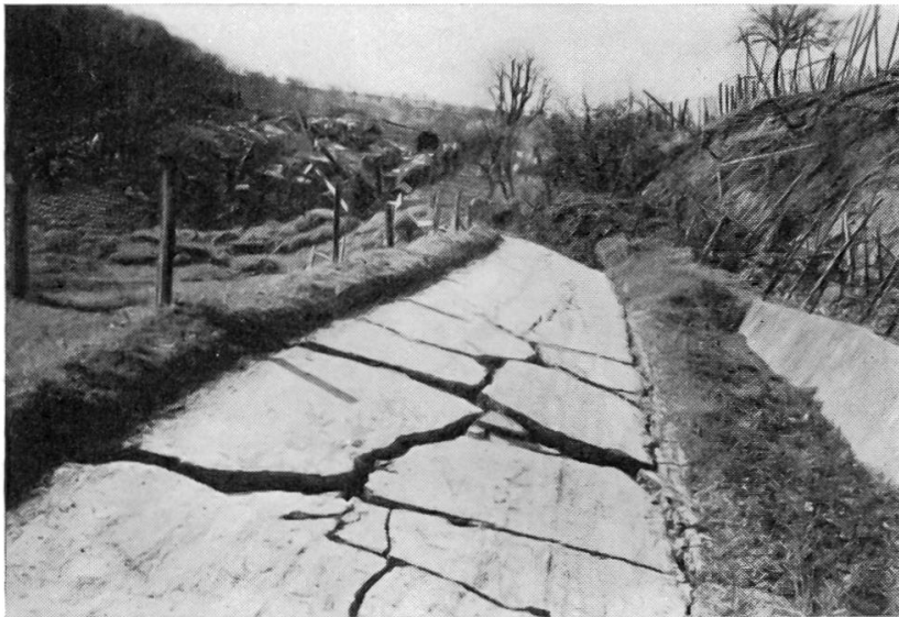
Abbildung 37. Untere Teilrutschung. Weinthagstrasse, durch Drehbewegung der «Depressions»-Scholle bergwärts geneigt. Strasse durch Verschiebung gegen «Doppelwohnhaus»-Scholle und gegen den auf derselben vorstossenden Wulst der mittleren Teilrutschung abgeschnitten. Photo JECK, Basel, 8. April 1952, nachmittags
