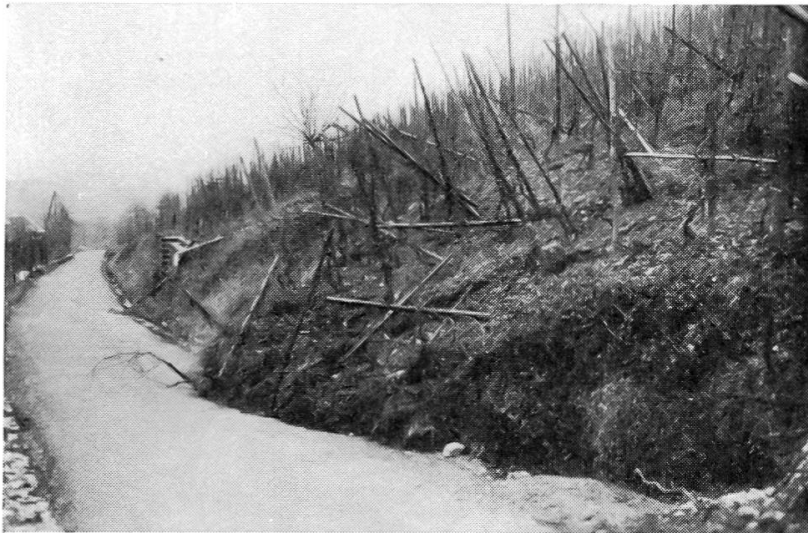
Abbildung 30. Rutschung vom November 1952 am nordwestlichen Rand des Rutschgebietes zwischen Neusetzstrasse und Schauenburgerstrasse. Überschiebung des Wulstes auf die Schauenburgerstrasse. Photo des Verf. 6. Dezember 1952
