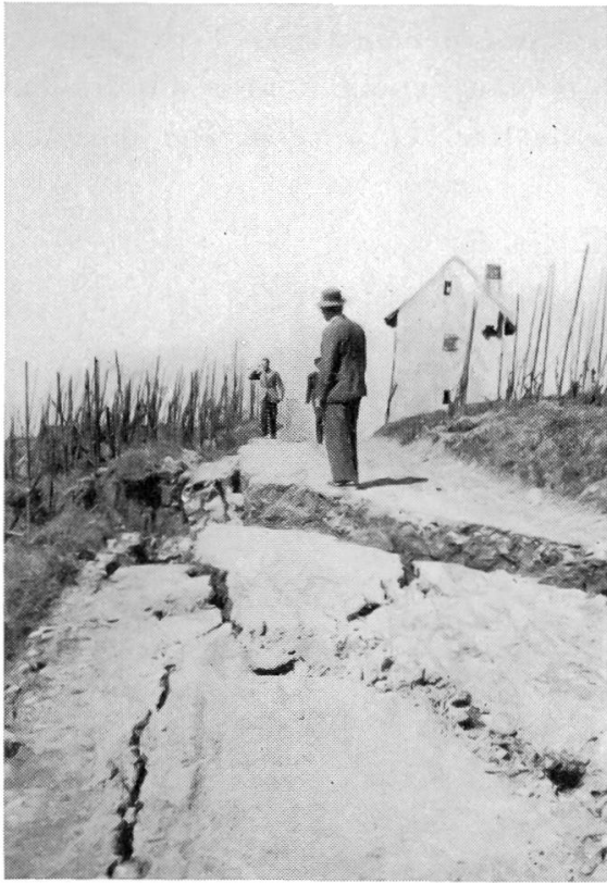
Abbildung 23. Abriss West der mittleren Teilrutschung. Beginnender Abriss der oberen Teilrutschung südöstlich des Bannwarthhauses. Hallenweg und Bannwarthhaus durch die Drehbewegung der oberen Teilrutschung schiefgestellt.
