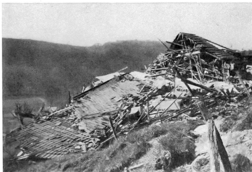
Abbildung 36. Untere Teilrutschung. Doppelwohnhaus und Weinthagstrasse von Osten. Verschiebung der Weinthagstrasse durch Verschiebungskluft zwischen «Doppelwohnhaus»-Scholle und «Depressions»-Scholle. Trümmer des Doppelwohnhauses infolge Überschiebung des Wulstes gegen die Talseite gekippt.
