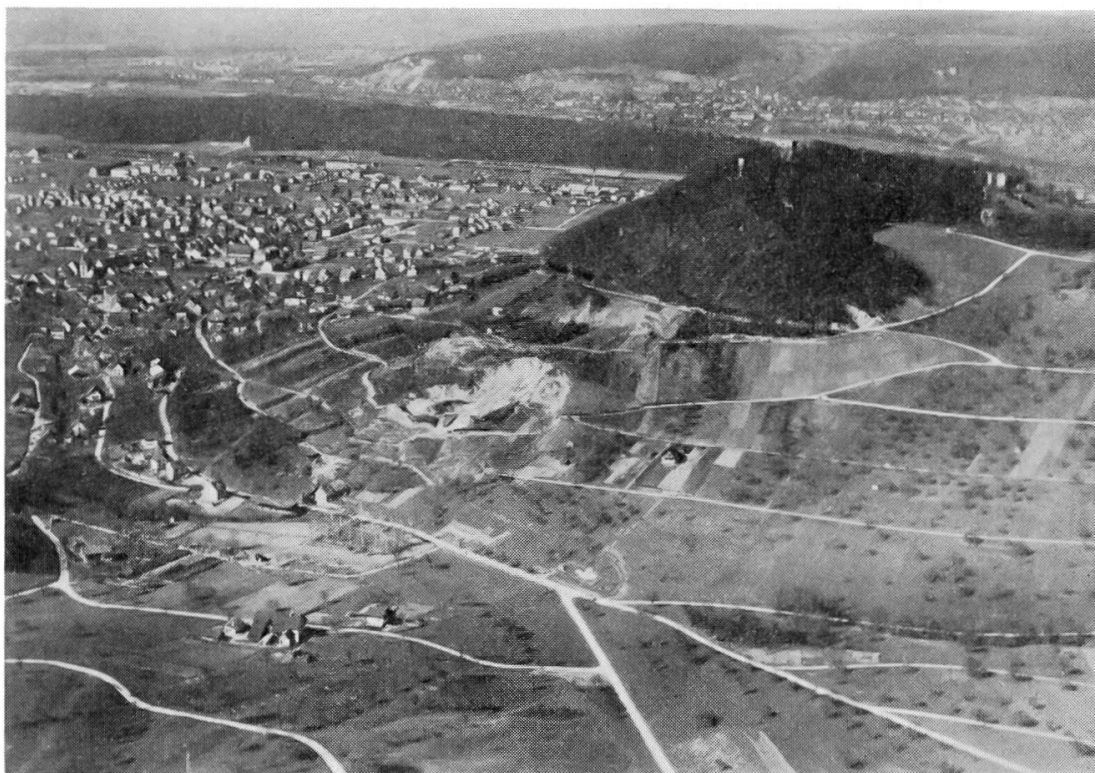
Abbildung 1. Ansicht des Wartbergs von Süden mit Rutschgebiet des Südwestabhangs. Flugaufnahme: Foto HOFFMANN, Basel, 9. April 1952.
