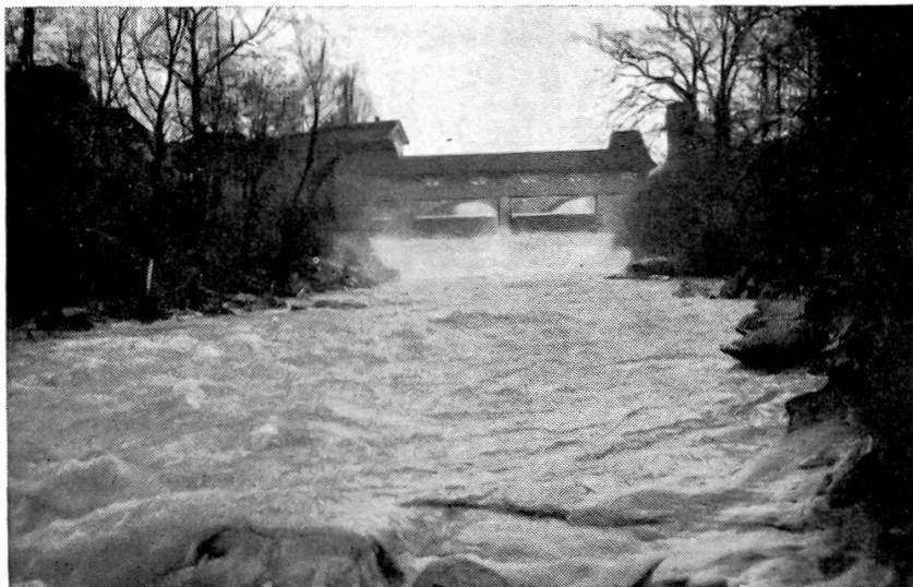
Abbildung 108. Vom Kanal der Spinnerei Arlesheim umflossene Birsstrecke bei winterlichem Hochwasser. Bei Hochwasser nimmt die Strecke einen vollständig veränderten Charakter an. Das Bild wurde bei einer Abflussmenge von etwa 60 \text{ m}^3/\text{sec} aufgenommen. 4. 1. 1948 (Phot. H. S.)
