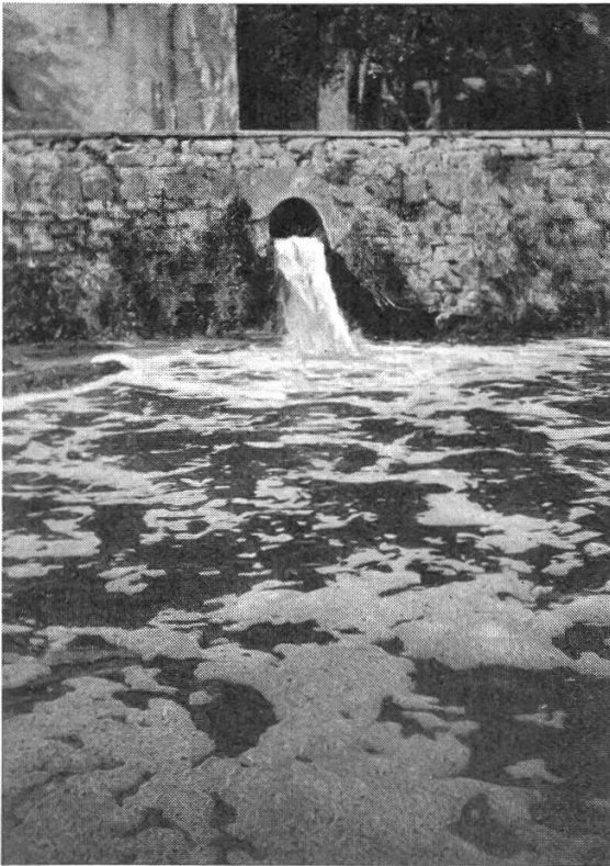
Abbildung 15. Überfall des Unterwasserkanals der Aktienmühle in Augst in die Ergolz. Starke und lange stehende Schaumbildung infolge des hohen Gehaltes des Wassers an organischen Substanzen. 12. 9. 29.
