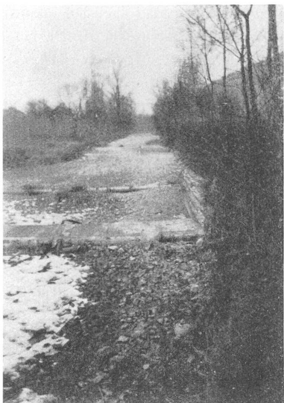
Abbildung 7. Ergolz unterhalb des Wehrs zum Kanal der Sägerei in Itingen. Vom Kanal umflossene Strecke; ohne Grundwasseraustritte, weil kurz oberhalb der Gefällsstufe für den Kanal der Papierfabrik Lausen gelegen. Sickerwasser des Wehrs und mit dem Bächlein von Itingen zufließendes Wasser versickert kurz unterhalb des Wehrs in den Schottern. Mittlere Abflussmenge der Ergolz am 30. 12. 32 0.9 \text{ m}^3/\text{s} .
