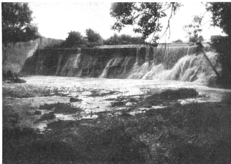
Abbildung 14. Wehrpritsche (Hülftenpritsche) zum Kanal der Aktienmühle in Augst. Starke Zerstäubung des Wassers ermöglicht die Aufnahme von Sauerstoff. Mittlere Abflussmenge 0.9 \text{ m}^3/\text{s} . 29. 12. 32.
