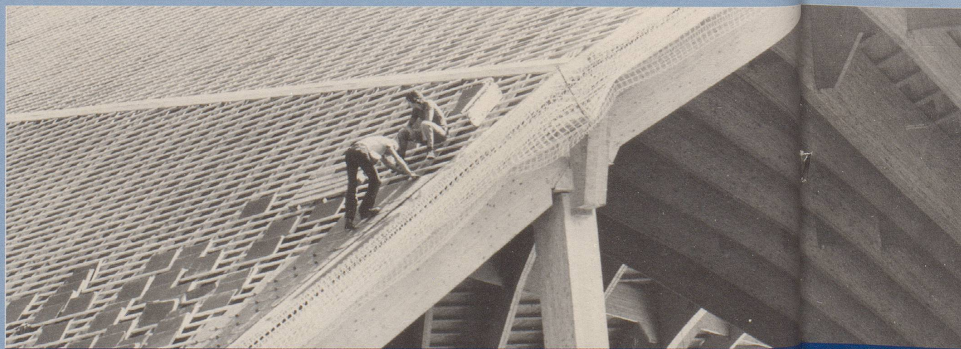
6. Auch dort, wo die neuen Infrastrukturen noch nicht bereitstehen ...
