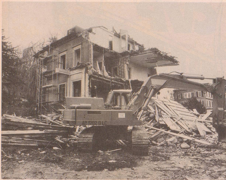
Die Verbesserung der eidgenössischen Bausubstanz ...
