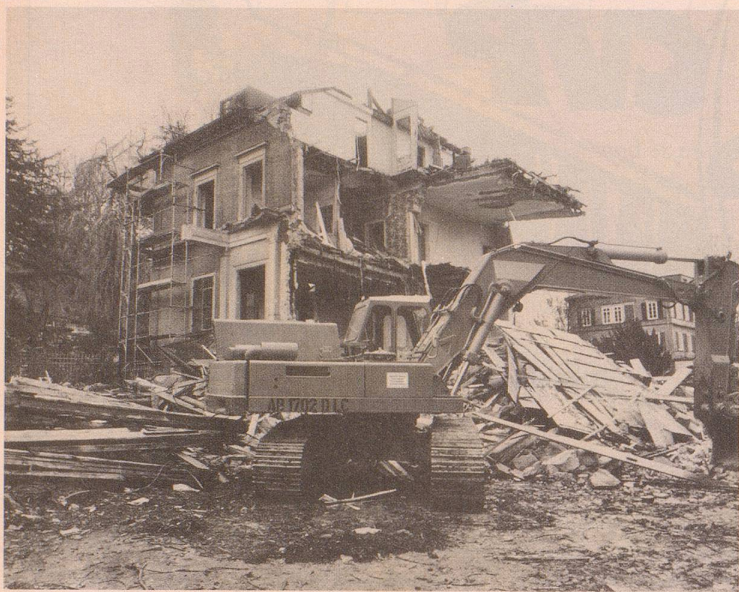
Die Verbesserung der eidgenössischen Bausubstanz ...
