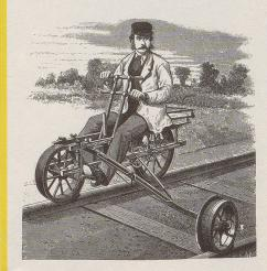
Aus dem amerikanischen Bundesstaat Michigan stammt das um 1880 konstruierte Eisenbahn-Velociped, mit dem durch den Hand- und Fuss-Kurbel-Mechanismus eine Fahrgeschwindigkeit von rund 20 Stundenkilometern erreicht wurde.
