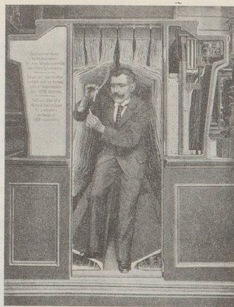
Was in unserer Gegenwart der moderne Telefontechniker beim Chipslöten als Computerfachmann praktiziert, das war 1903 der Herr Fernsprechengeieur mit dunklem Anzug und Vaternörderkragen im Amt IV in Berlin. Wir sehen den Kabelgang eines Vielfachschalters für eine Telefonzentrale von 14000 Teilnehmern. Da gab es für das Fräulein vom Amt noch Hunderte von Kontroll- und Sprechschlusslämpchen, Rufzeichenklinken, Abfragestöpsel und Prüfstöpsel.
