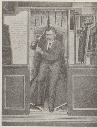
Was in unserer Gegenwart der moderne Telefontechniker beim Chipslöten als Computerfachmann praktiziert, das war 1903 der Herr Fernsprechengeieur mit dunklem Anzug und Vatermörderkragen im Amt IV in Berlin. Wir sehen den Kabelgang eines Vielfachschalters für eine Telefonzentrale von 14000 Teilnehmern. Da gab es für das Fräulein vom Amt noch Hunderte von Kontroll- und Sprechschlusslämpchen, Rufzeichenklinken, Abfragestöpsel und Prüfstöpsel.
