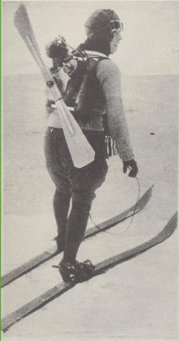
Mit dieser Erfindung trat 1924 ein Berliner Ingenieur an die Öffentlichkeit. Der Motorrucksack mit Luftschaube ermöglichte es dem Skifahrer, auf Schne- und Eisflächen grosse Geschwindigkeiten zu erreichen.
