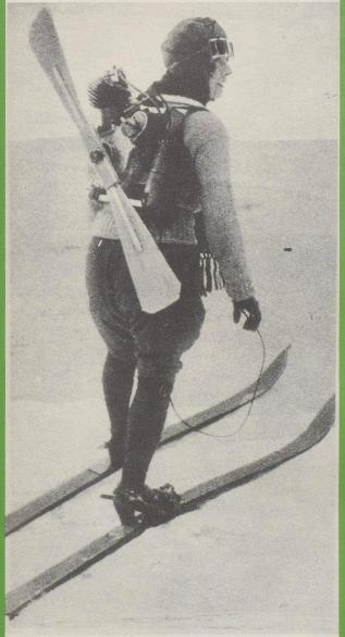
Mit dieser Erfindung trat 1924 ein Berliner Ingenieur an die Öffentlichkeit. Der Motorrucksack mit Luftschraube ermöglichte es dem Skifahrer, auf Schnee- und Eisflächen grosse Geschwindigkeiten zu erreichen.
