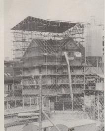
7 Das verbliebene, älteste Gebäude der Stadt an der am dichtesten befahrenen Strasse. Um die sehr delikate Fassade vor den Abgasen zu schützen, wird hier erstmals das kostspielige «Haus-im-Haus-Verfahren» realisiert, bei welchem das schützenswerte Gebäude eine permanente Plastikhülle erhält.
