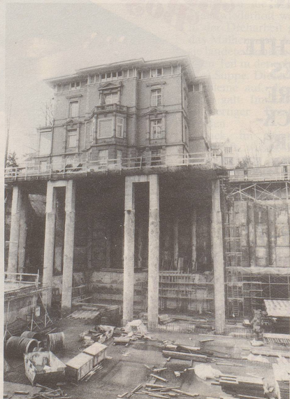
5 Diese Jugendstilvilla gehört dem reichsten Zahnarzt der Stadt und steht auf dem teuersten Boden. Das historisch bedeutsame Bauwerk ist jetzt in die Höhe gehoben worden, damit wie geplant auf Strassenniveau eine Bank erstellt werden kann. Eine vorbildliche Lösung, die hoffentlich Schule macht!
