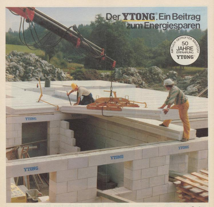
Um den jetzt vorgeschriebenen Wärmedurchgangs-Koeffizienten zu erreichen, brauchen übliche Baustoffe zusätzliche Dämmschichten. Oder die Außenwände müssen stärker dimensioniert werden. Der YTONG erfüllt schon seit 50 Jahren die energiesparenden Normen von heute und übertrifft sie schon mit einer 25 cm-Wand.
