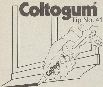
Der undichte Wetterschenkel an der Ausenseite des Fensters lässt sich leicht selbst in Ordnung bringen, indem ein Strang Collogum daruntergedrückt wird. Direkt aus der Tube oder aus der Kartusche.
